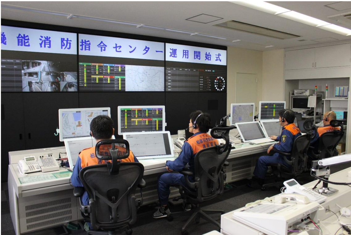
高機能消防指令センター
